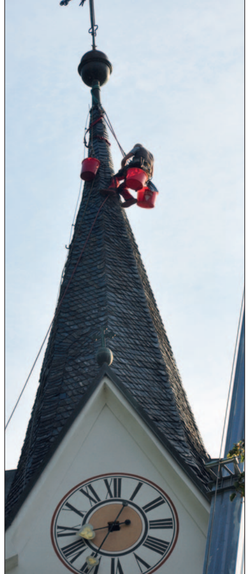
ein Gipfelerlebnis der besonderen Art - dringende Reparaturarbeiten am Turm der Trinitatiskirche
