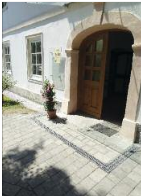
Der Eingang zum Pfarrhaus nun ohne Stufe zugänglich – damit ist die Barrierefreiheit sowohl im Pfarrhaus (Inkl Toilettenanlage), als auch in der Kirche gewährleistet.
